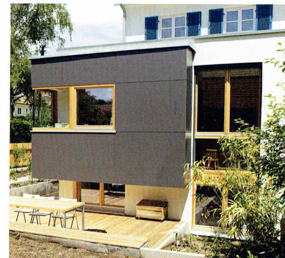
Der historischen Fassade wurden ein moderner Wintergartenanbau mit hinterlüfteter Plattenfassade und eine neu gestaltete Holzterrasse zugefügt.
